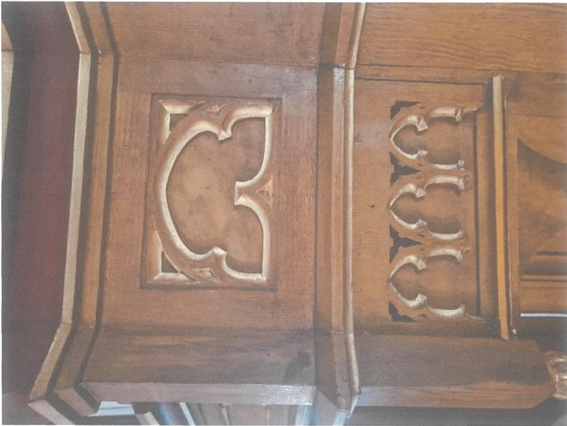
3. Otwory wylotowe świadczące o obecności kołatków.
